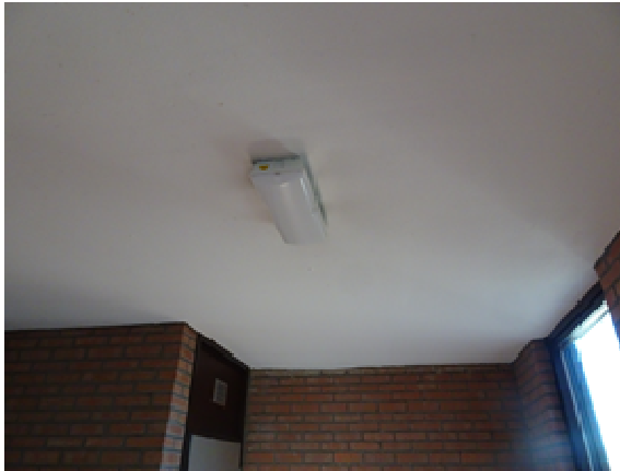
Foto 2. Het plafond vertoont deze keer na de opknapbeurt geen blaasvorming meer.
