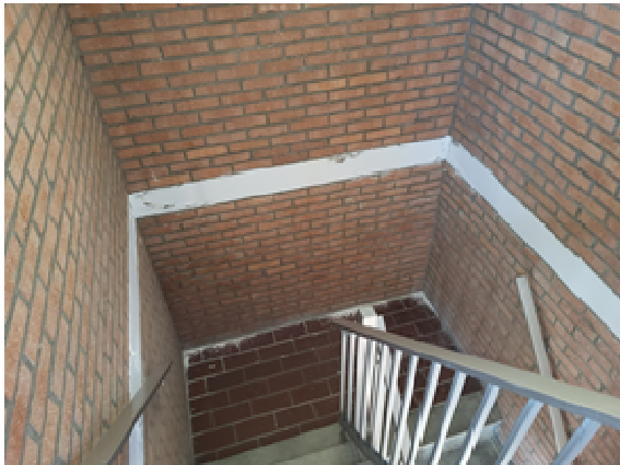
Foto 1. Afgebladderde coating en blaasvorming als gevolg van vocht.
