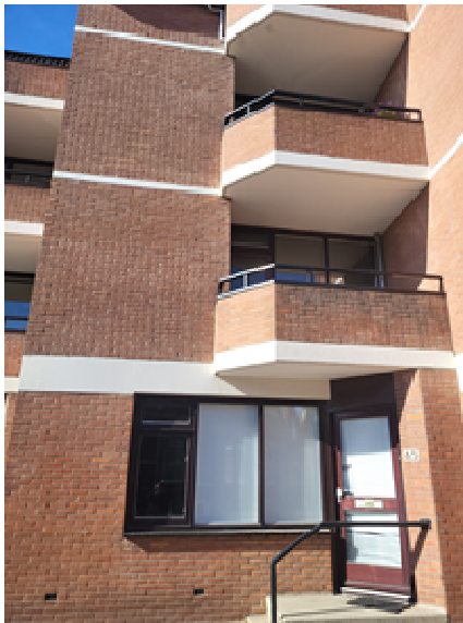
Foto 5. Vervuiling en mosaangroei metselwerk borstwering balkon (voorzijde).
